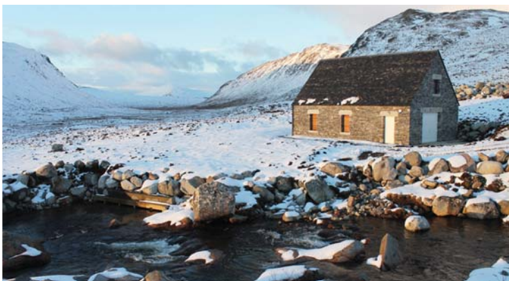
Uisge Labhair Powerhouse
